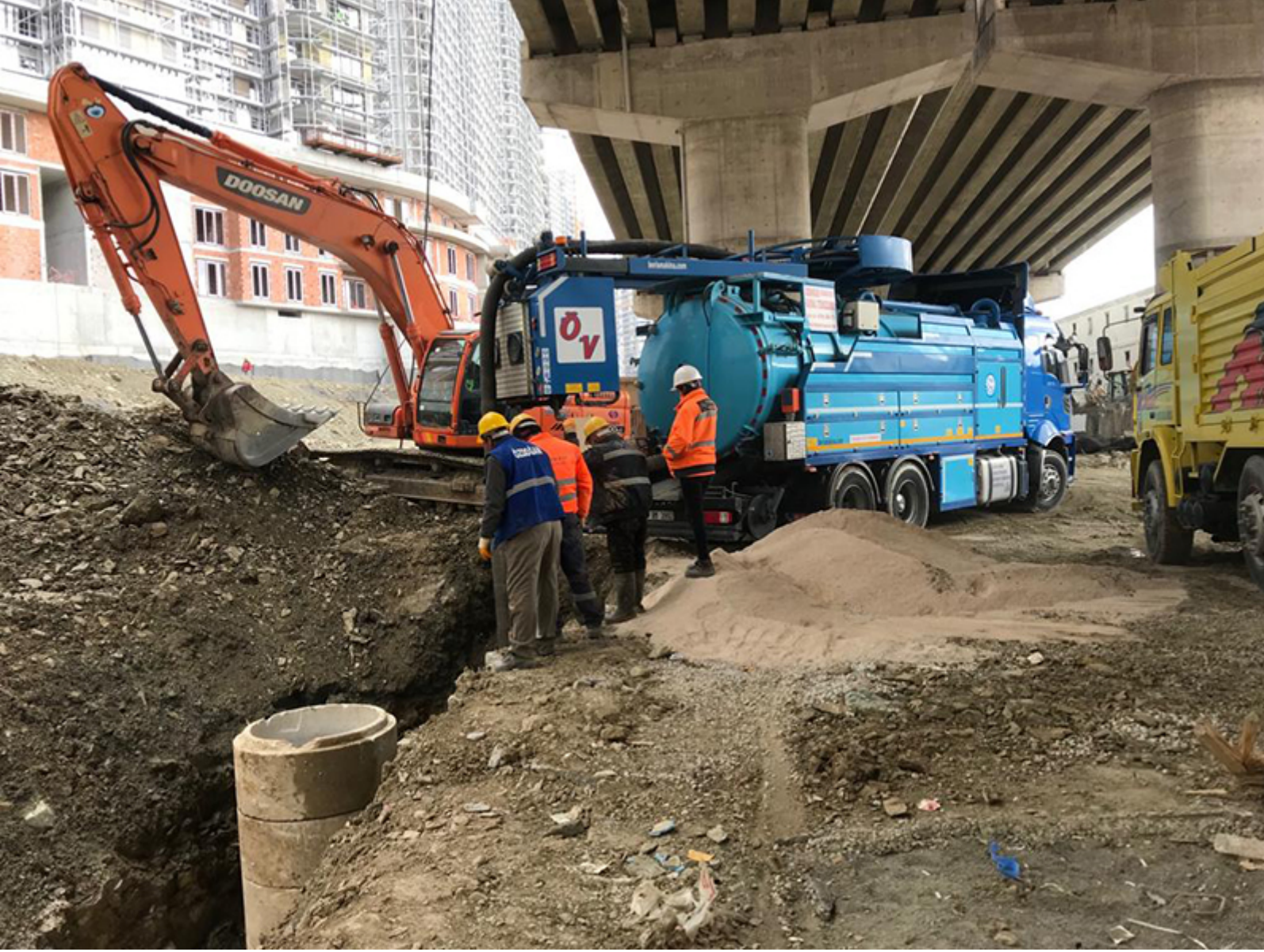
Kanalizasyon Hat Yenileme İşleri
