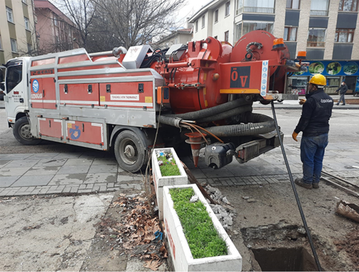
Kanalizasyon Açma Projesi (3)
